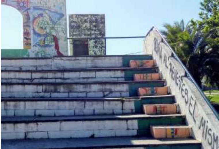
FOTO 2 - SECTOR DE GRADAS DEL LADO DEL ARCO 1
