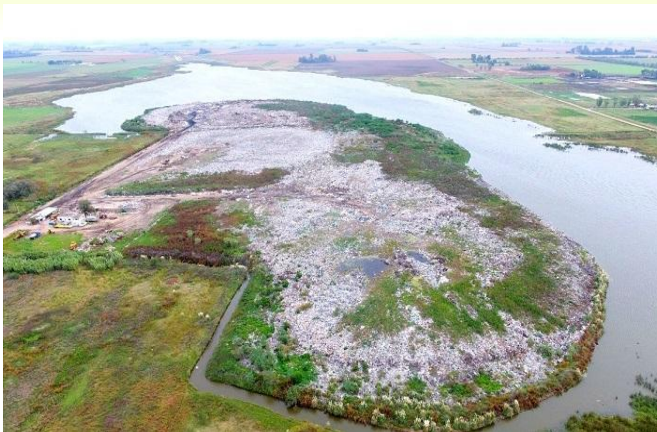
Basural a cielo abierto sobre los márgenes de la Laguna Las Aguadas
