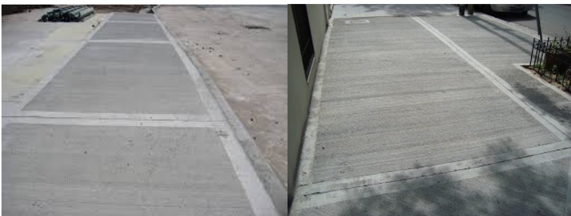
Modelo de terminación de veredas.
