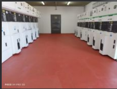
CELDAS COMPACTAS DE MEDIA TENSIÓN
